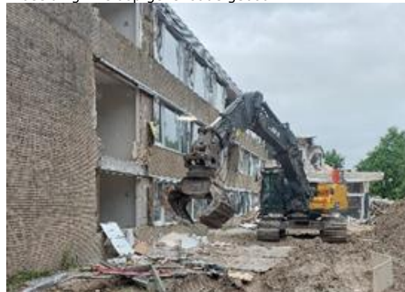
Afbeelding 2: sloop gevel oude gebouw
