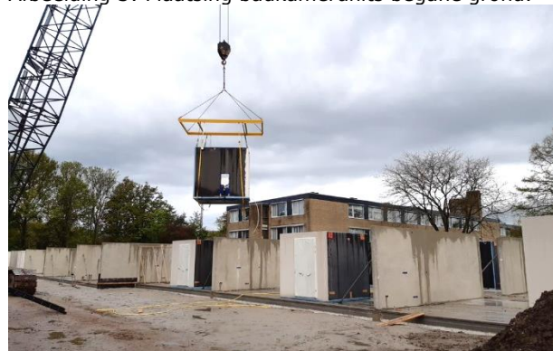
Afbeelding 3: Plaatsing badkamerunits begane grond.
