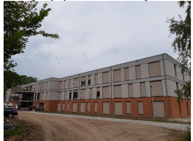
Afbeelding 4: Tijdelijke entree aan achterkant gebouw
