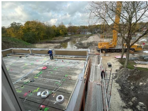
Figuur 4 Dak aanbouw nieuwe de Hoorn
