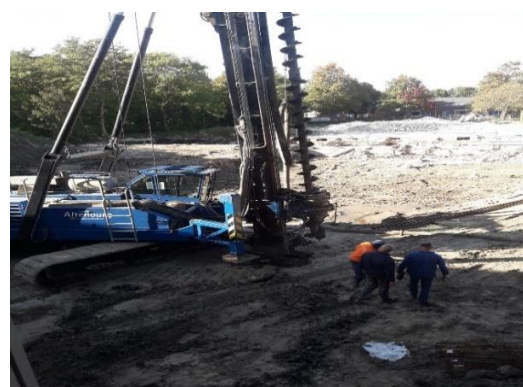
Figuur 3 Boren gaten voor het fundament
