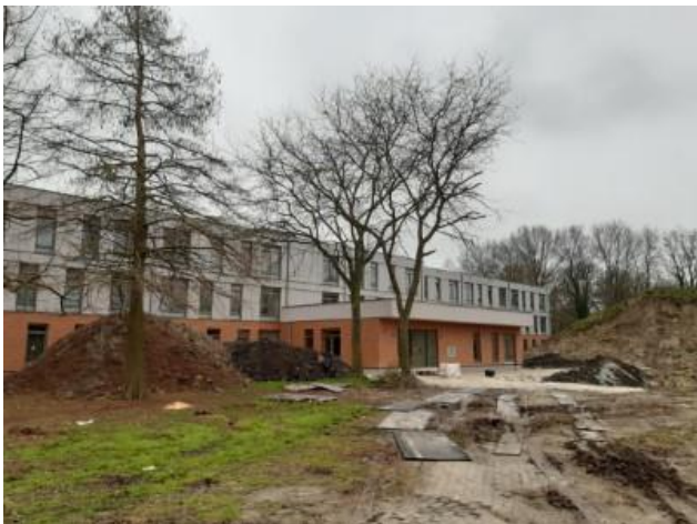
Afb. 4 nieuwe entree, nog niet toegankelijk.
