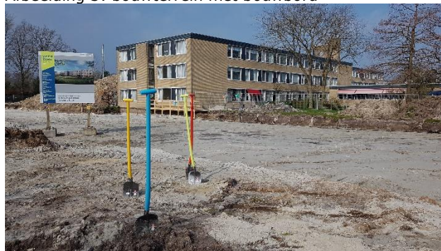
Afbeelding 3: bouwterrein met bouwboard
